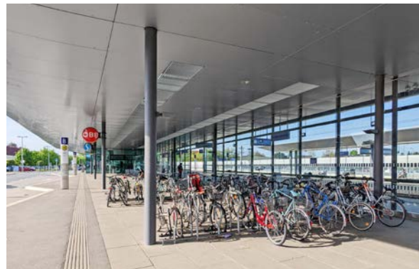
Direkt am Bahnsteigzugang platzierte Bike&Ride-Anlage
