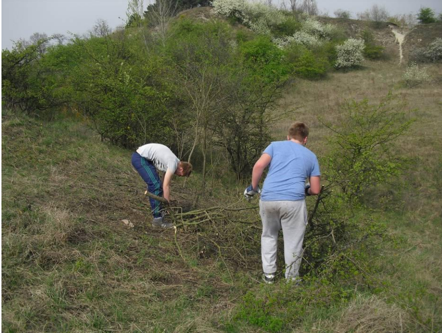
Abb. 31: Entfernen von Gehölzen an der Kante des ehemaligen Schotterabbaus im „Lasseer Weingarten“ im April 2014.
