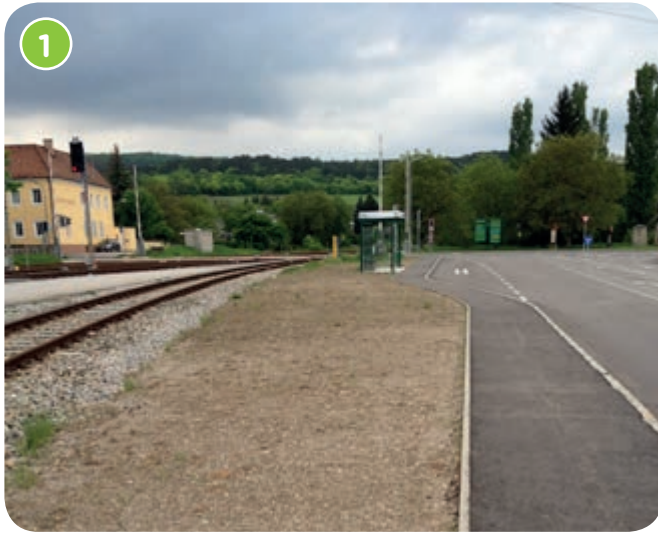
1 Bodenvorbereitung kurz vor der Aussaat. Möglichst frei von Bewuchs, mager und gut planiert.
