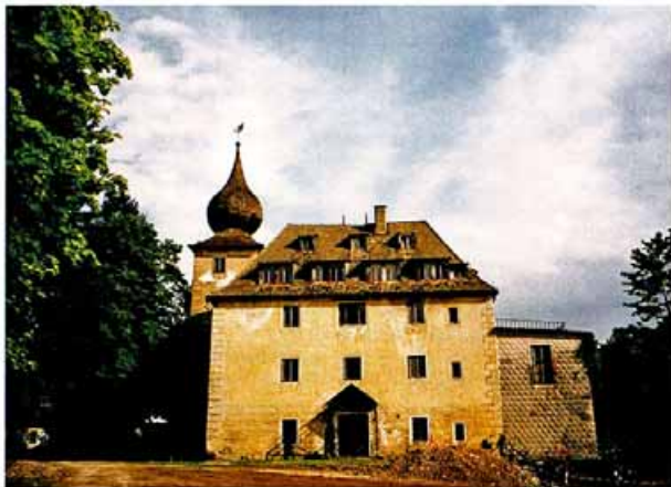
Zell/Ybbs, NO Schloss, vor Baubeginn, von Süden
