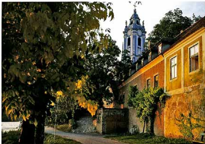
Dürnstein, Stiftsturm, Uferbau
