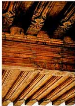
Zell a.d. Ybbs, NO Holzbalkendecke, 1610
