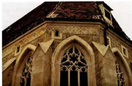
Stein, Chor der Pfarrkirche nach Restaurierung
