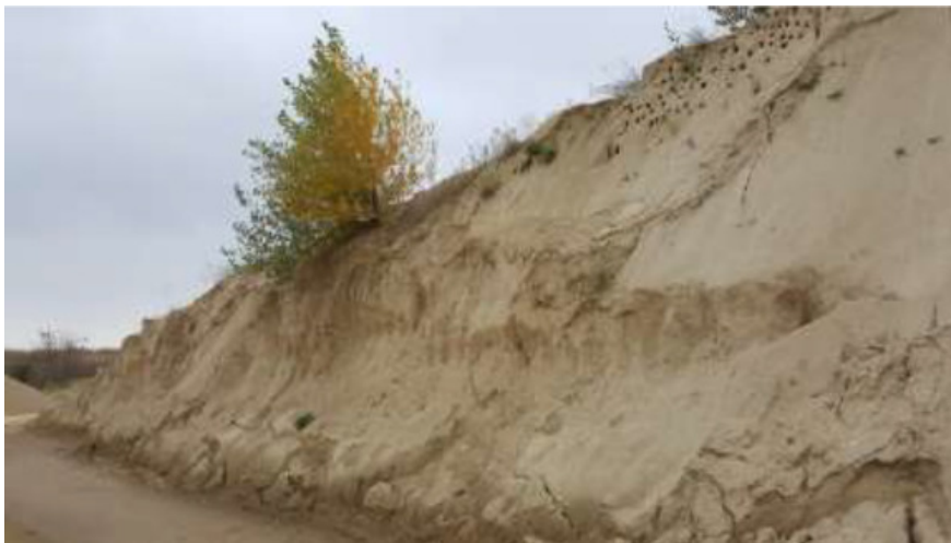
Abbildung 2: Versteilte Brutwand in der Kiesgrube Schwadorf (Photo: Frank Grinschgl)
