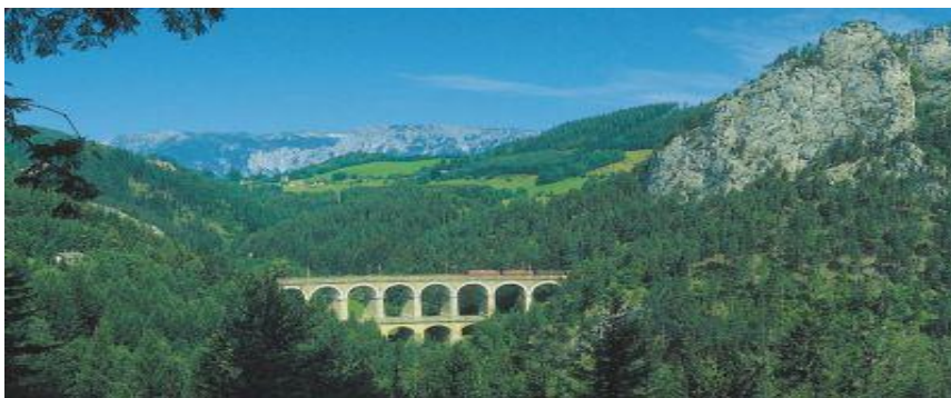
Bild 7: Semmeringbahn (Viadukt über die „Kalte Rinne“)
