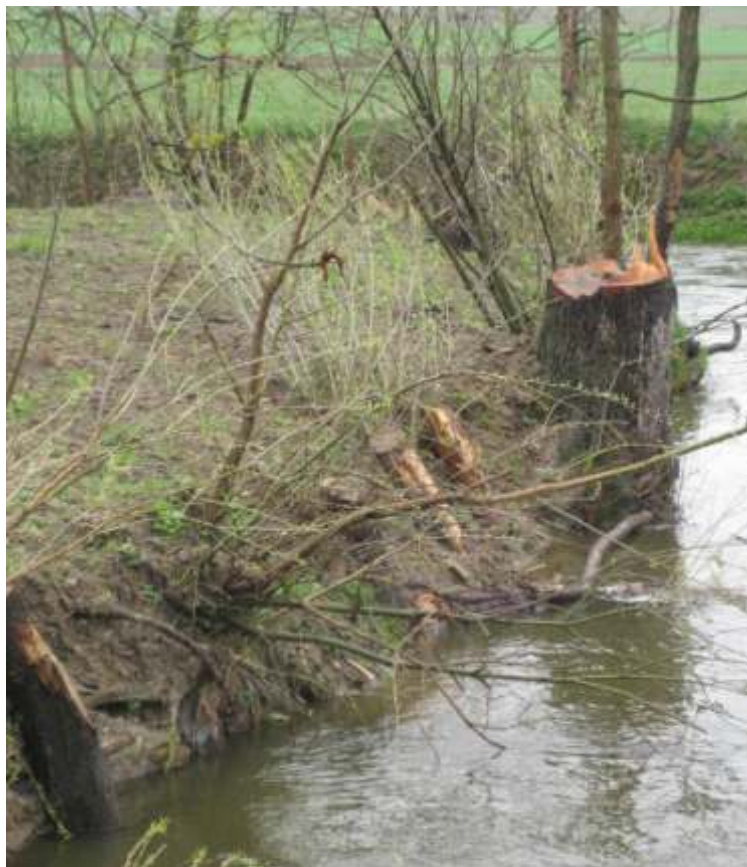
Fertiger Holzpilotenverbau mit Weidenastrieb
