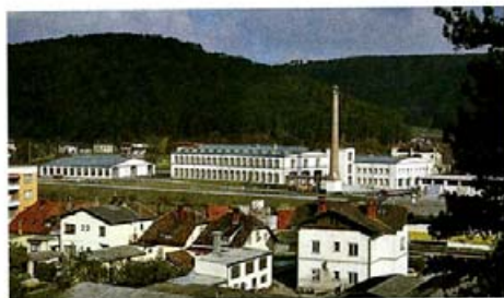
Die Anlage nach der Revitalisierung
