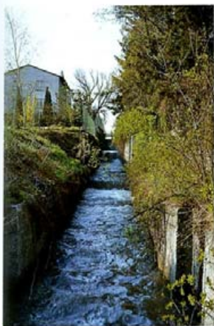
Wiener-Neustädter-Kanal, NÖ, erbaut 1797–1803
