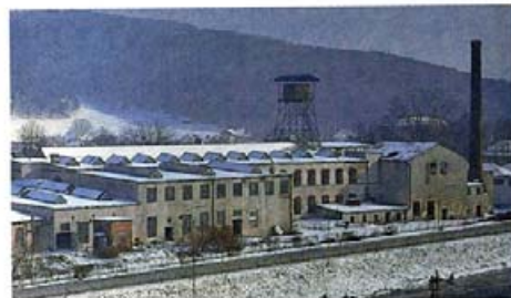
Vor Beginn der Arbeiten Anfang 1986
