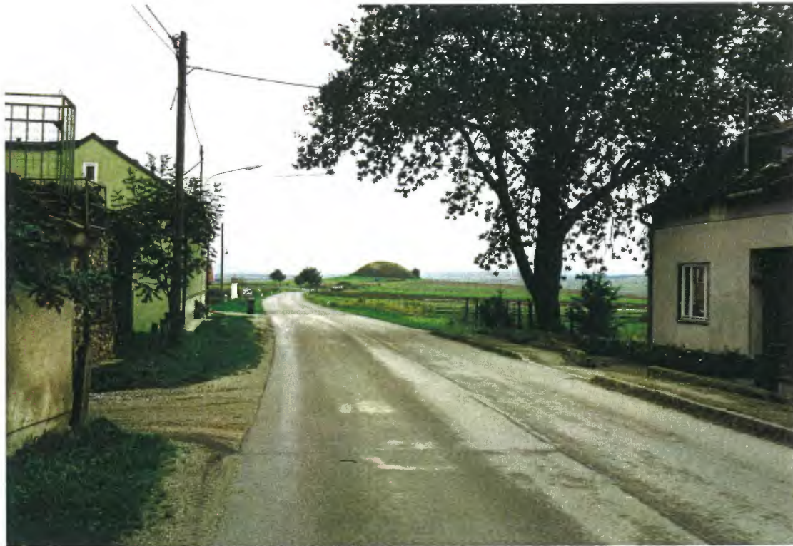
Ortsausfahrt Niederhollabrunn Blickrichtung: West Streitdorf (West)
