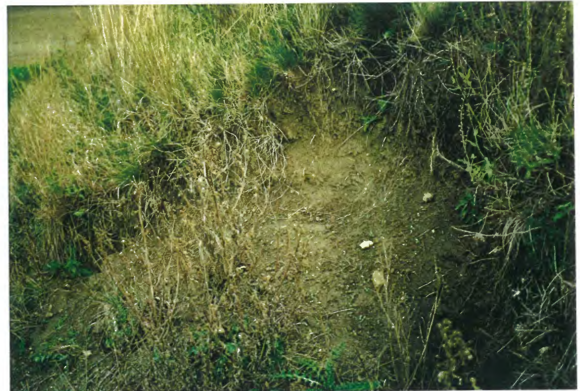
Erosionsschaden Leeberg Niederhollabrunn Verbuschung und Erosionsschäden
