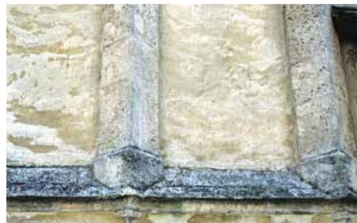
*Pöggstall, Schloss Rogendorf, oberer Arkadengang: ziegelroter Estrich um 1540 (nach Restaurierung des Schlosses im Jahr 2016). Die dunkleren Stellen sind Ergänzungen, die Ränder an den Mauern zeigen noch die ursprüngliche rote Deckschicht.*
