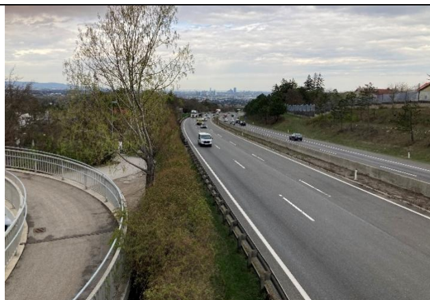
Blick über die Autobahn. Im Hintergrund liegt Wien. (Brücke bei ca. km 33,0).
