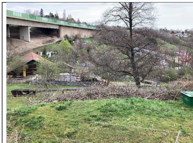
Blick auf Brücke bei Gießhübl, ca. km 30,9.
