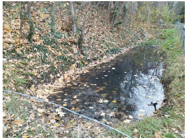
Abbildung 34: Bereich der östlichen Gewässerschutzanlagen im November
