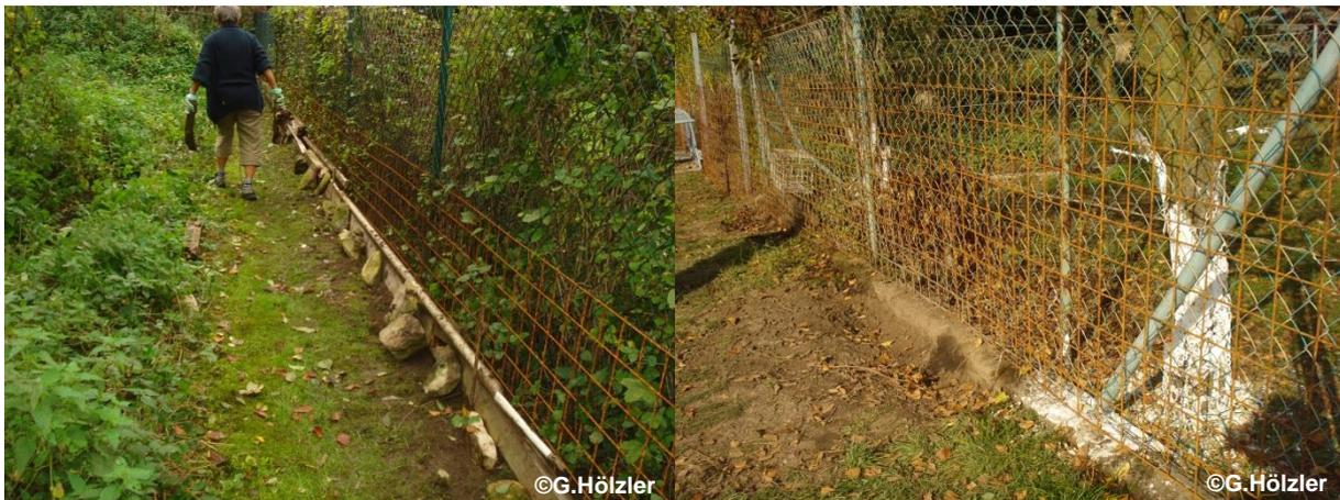
**RICHTIG: Baustahlgitter in Kombination mit Befestigungsmaterial dicht am Boden verbessert die Schutzwirkung von bestehenden Zäunen, Holzmaterialien eignen sich nur bedingt dafür und sollten zusätzlich mit Drahtauflagen versehen werden**
