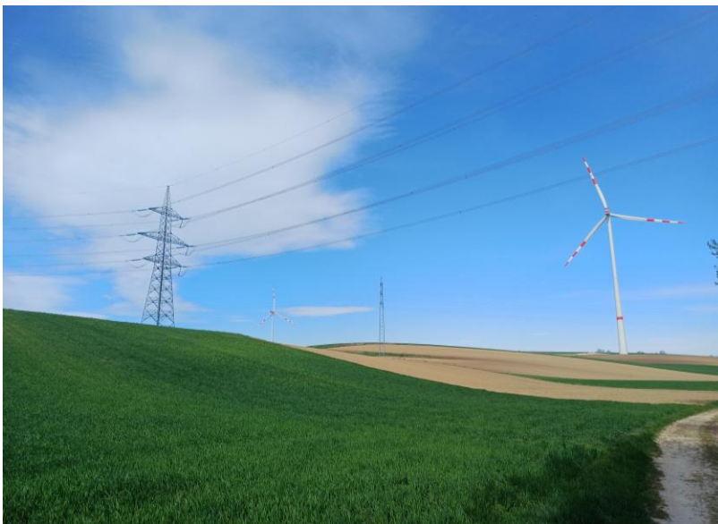
Westlich der geplanten WEA 2 befindet sich eine Hochspan- nungsleitung sowie bestehende WEA des WP LOI II, Blick in Richtung Westen
