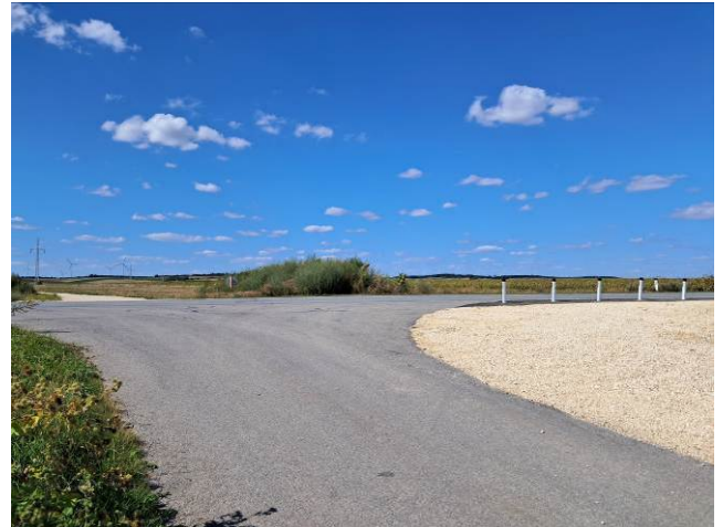
Abbildung: nordöstliche (temporäre) Anbindung an die L 15 – Ausfahrt vom Verbindungsweg von der L 3039 kommend (Aufgrund des Fahrverbots über 7,5 t auf dem permanenten Weg fahren Baustellenfahrzeuge hier aus.) bzw. Ein- und Ausfahrt vom Windparkgelände.
