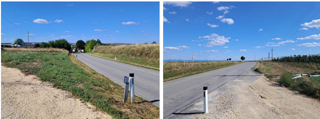
Abbildung: Sichtverhältnisse, nordwestliche auf die L 3026 – Blickrichtung Südwest (links) und Nordost (rechts)
