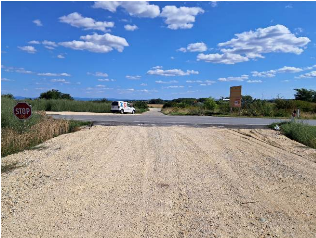
Abbildung: nordöstliche (temporäre) Anbindung an die L 15 – Ausfahrt vom Verbindungsweg von der L 3039 kommend (Aufgrund des Fahrverbots über 7,5 t auf dem permanenten Weg fahren Baustellenfahrzeuge hier aus.) bzw. Ein- und Ausfahrt vom Windparkgelände.
