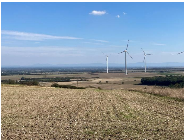
Blick von der L3041 Richtung Osten (eigene Aufnahme)
