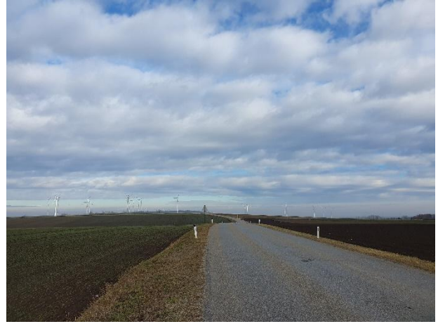
Blick von der L3039 Richtung Nordosten (eigene Aufnahme)
