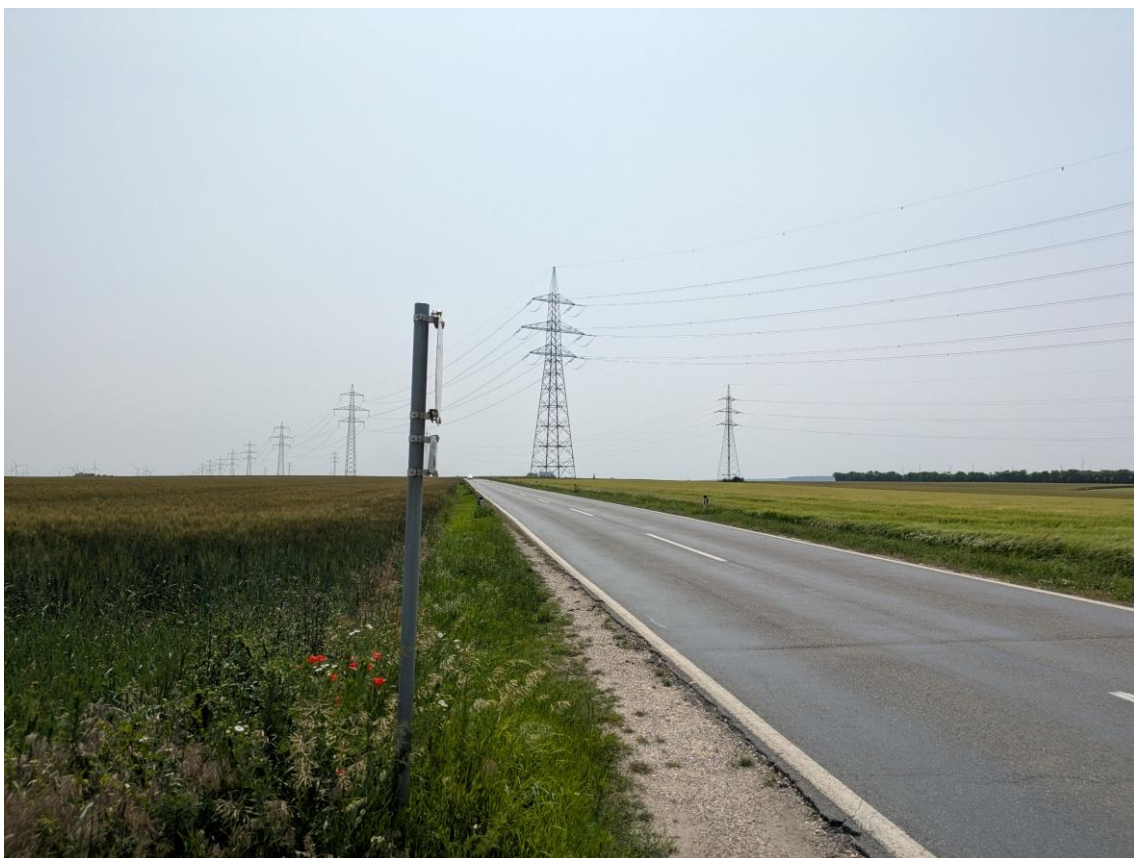
Abbildung 2: Anfahrsichtweite bei WP-Ausfahrt 1 an der L15, Blickrichtung Süden: ca. 280 m (Quelle: eigene Aufnahme)
