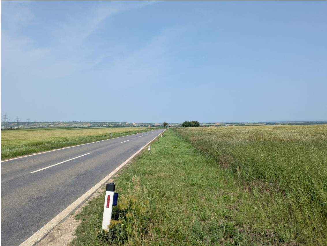
Abbildung 3: Anfahrtsichtweite bei WP Einfahrt 1 an der L15, Blickrichtung Nord: ca. 310 m (Quelle: eigene Aufnahme)
