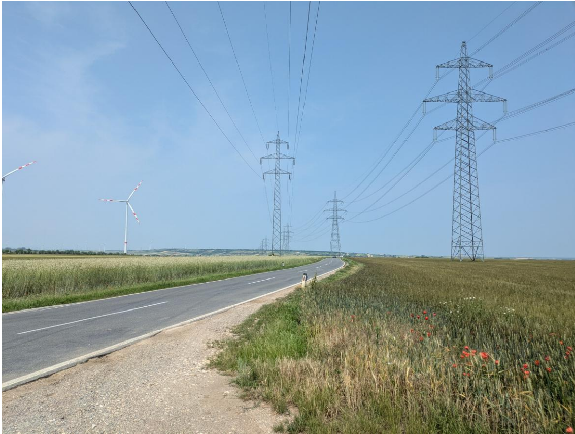
Abbildung 5: Anfahrsichtweite bei WP Einfahrt 2 an der L15, Blickrichtung Nord: ca. 380 m (Quelle: eigene Aufnahme)
