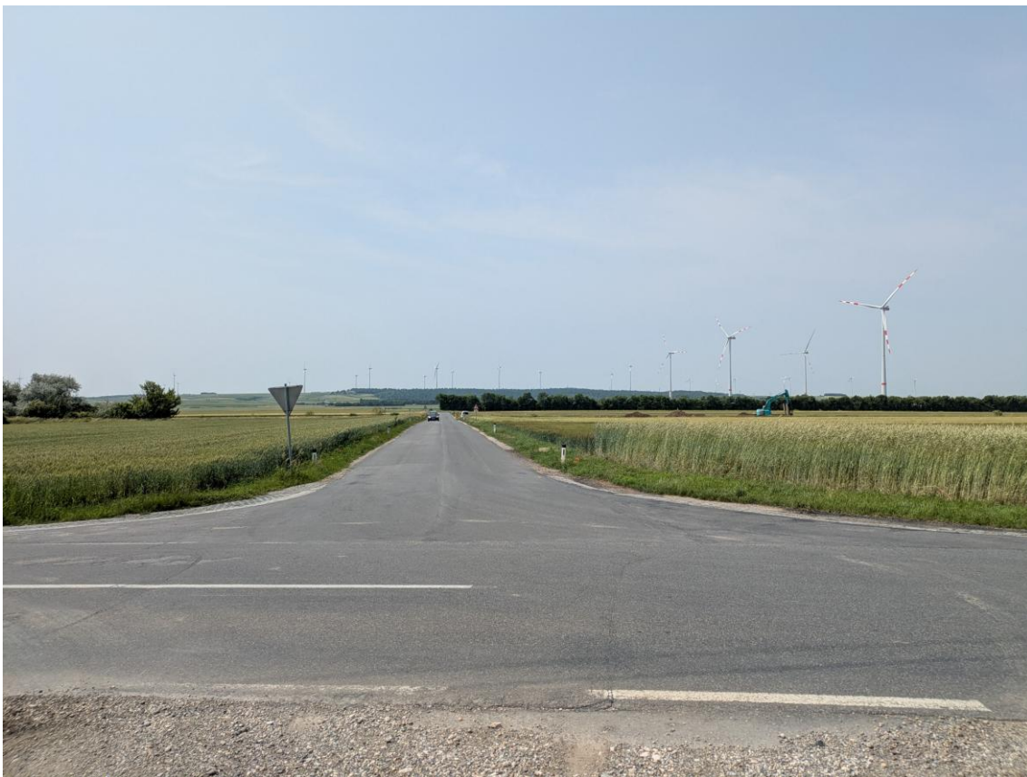
Abbildung 6: Anfahrsichtweite bei WP-Ausfahrt 2 an der L15, Blickrichtung Westen: ca. 460 m (Quelle: eigene Aufnahme)
