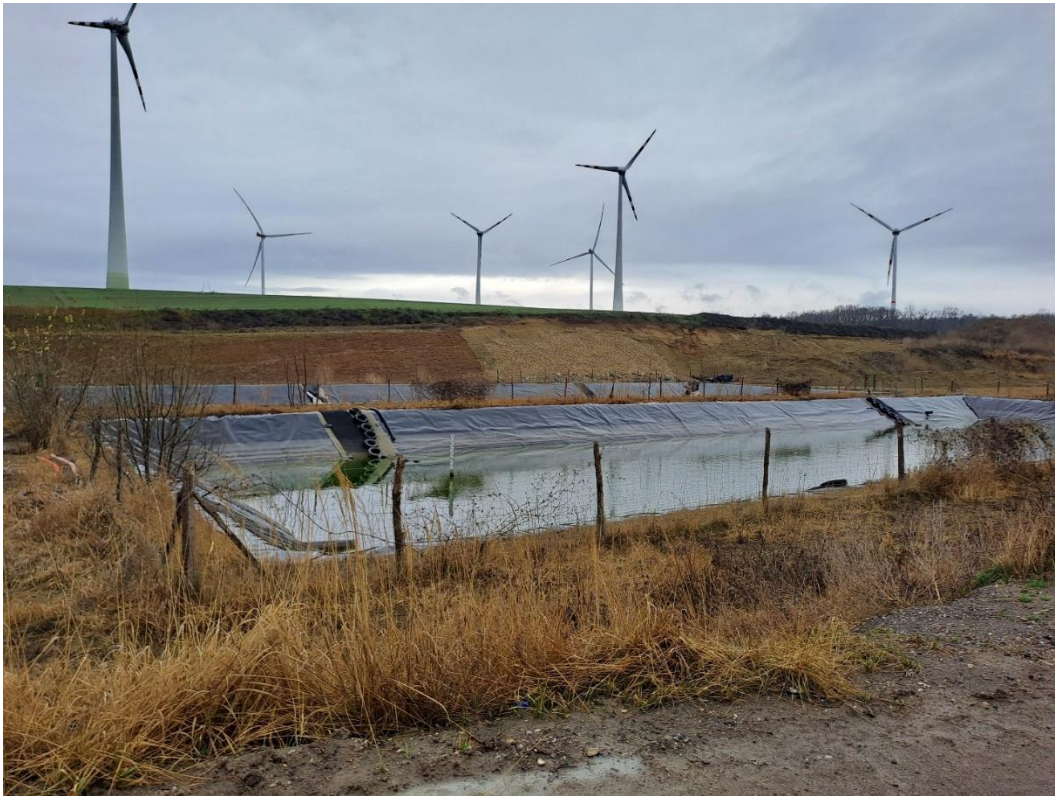
Abbildung 4: Entwässerungsbecken mit Zaun und Ausstiegshilfen (Quelle: eigene Aufnahme, 13.03.2025)
