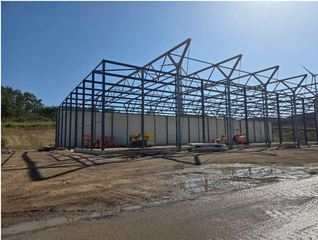
Abbildung 11: In Bau befindliche Halle (Quelle: eigene Aufnahme, 08.06.2026)
