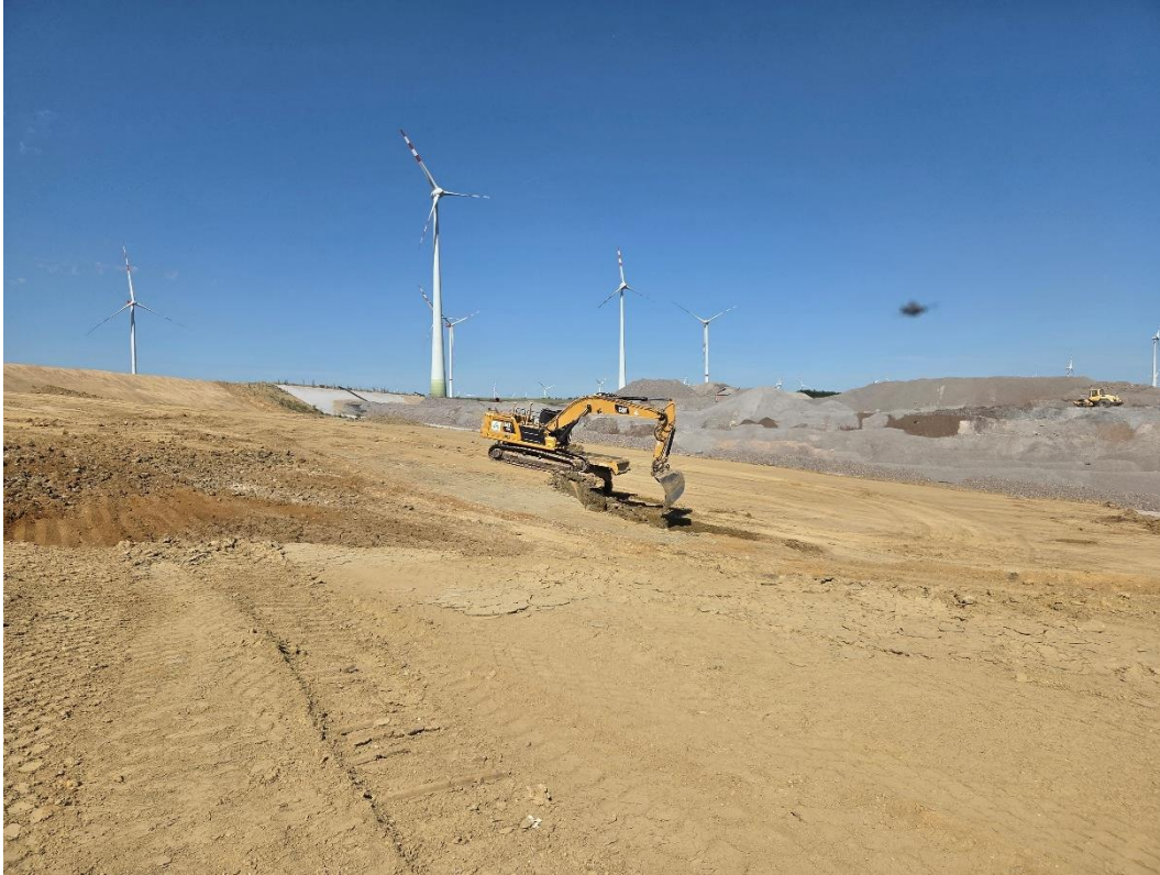
Abbildung 10: Offene Deponiefläche (Quelle: eigene Aufnahme, 08.06.2026)
