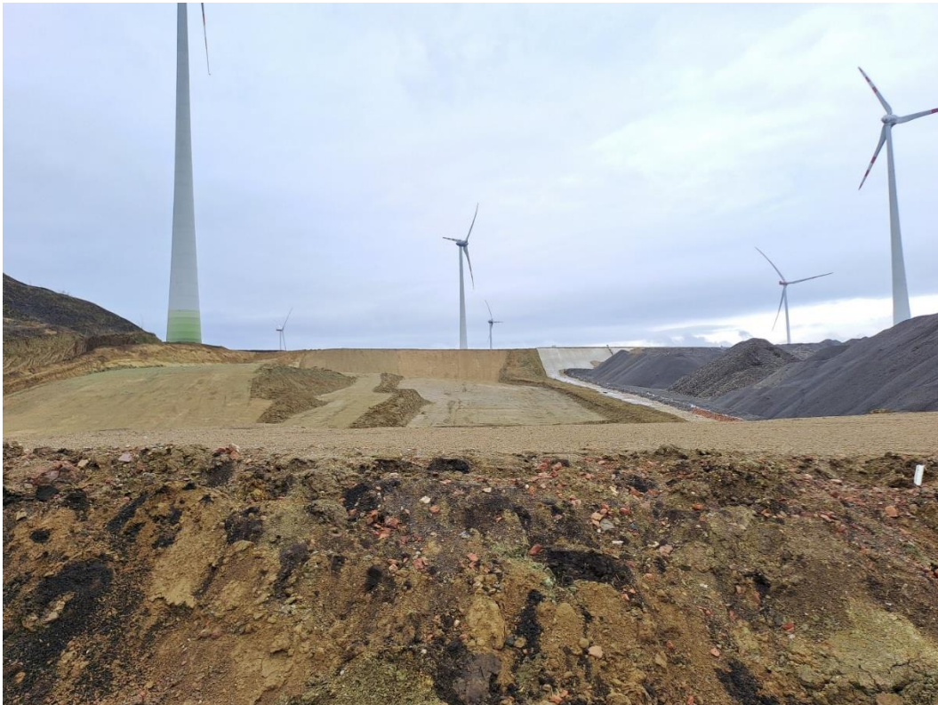
Abbildung 9: Offene Deponiefläche (Quelle: eigene Aufnahme, 13.03.2025)
