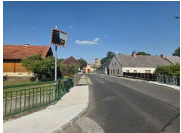
Blick von der Ortskapelle Richtung Osten
