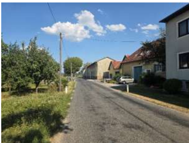
Blick von der L5076 Richtung Osten
