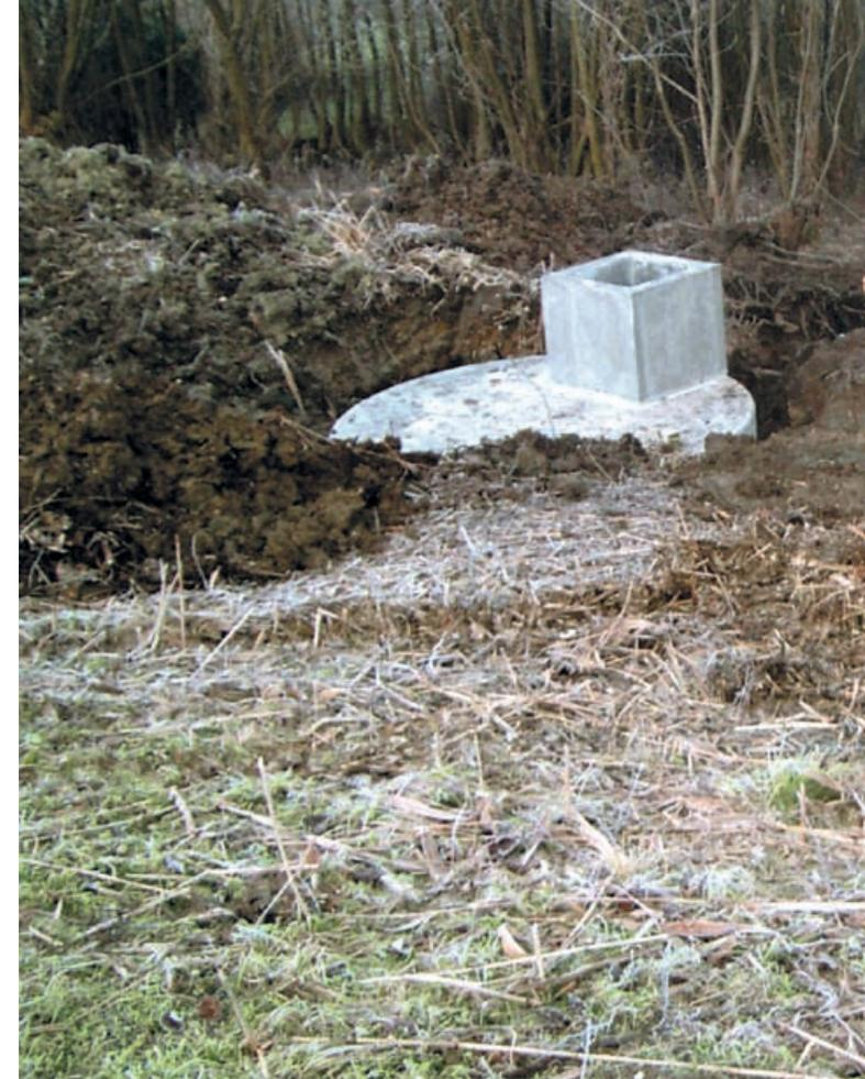
Um die Aufenthaltszeiten im Schacht kurz zu halten und möglichen Bakterienanwuchs hinten zu halten, ist auf eine gute Durchströmung des gesamten Bauwerkes zu achten. Oftmals ist es deshalb sinnvoll, die bestehende Anlage abzutragen bzw. außer Betrieb zu nehmen und daneben eine neue Anlage zu errichten.
