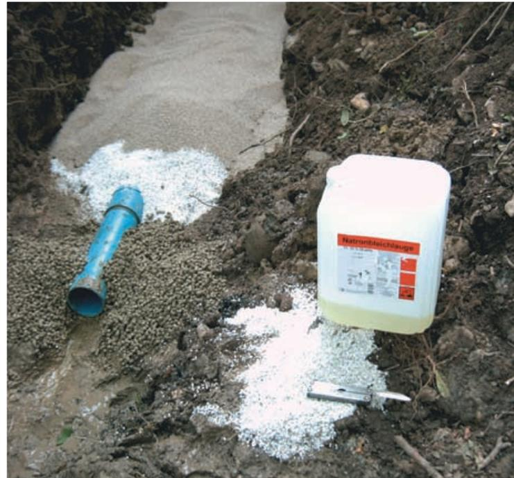
Das beim Freilegen gewonnene Material sollte nicht wieder für die Quelfassung verwendet werden. In der Regel wurde früher zu grobkörniges Material verwendet. Außerdem sollte bei der Neufassung von Quellen nur Quarzkies verwendet werden. Quarzkies enthält keine Nährstoffe und neigt deshalb nicht zur Verwurzelung.
