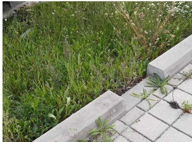
**Abbildung 23: Sickerfläche mit Gräser-Kräutermischung und Betongrenzstein als Überfahrtschutz des Grünstreifens**
