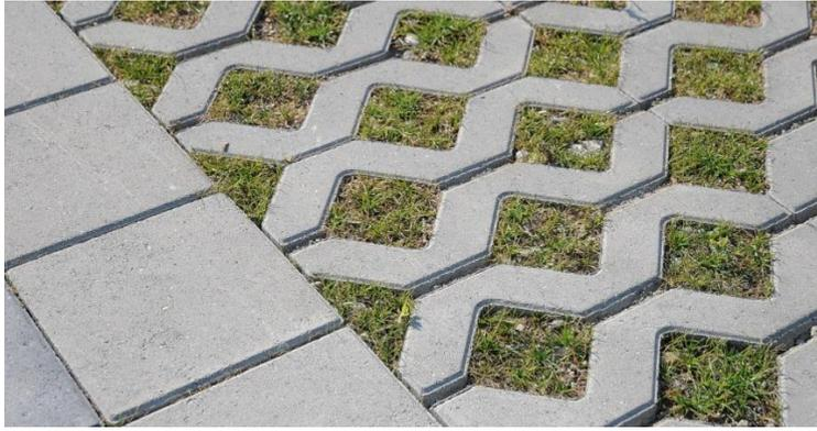
Abbildung 24: Kombination aus Drainpflaster und Rasengitterstein
