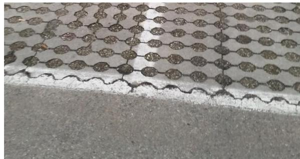
**Abbildung 28: Beispiel farbige Markierung Rasengitterstein und Anschluss an Asphaltfläche**
