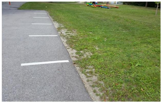
**Abbildung 30: Beispiel Schotterrassen mit Anschluss an Asphaltfläche und Parkplatzmarkierung**
