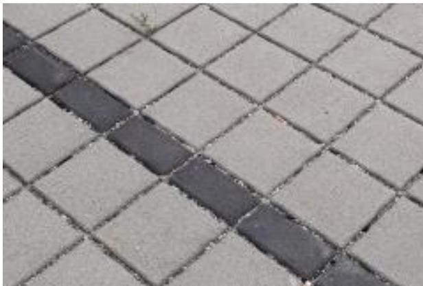
**Abbildung 20: Beispiel Markierung mit Betonstein**
