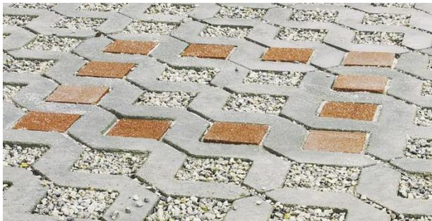
**Abbildung 27: Beispiel Stellplatzmarkierung mit Markierungsstein in ziegelrot**
