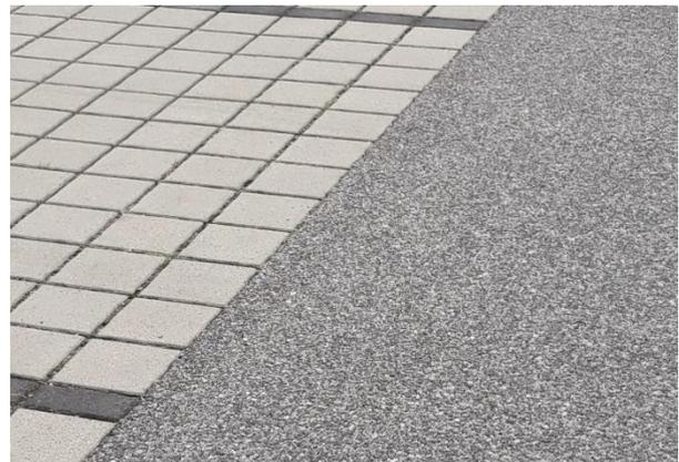
**Abbildung 21: Beispiel Anschluss Pflasterfläche an Asphaltfläche**
