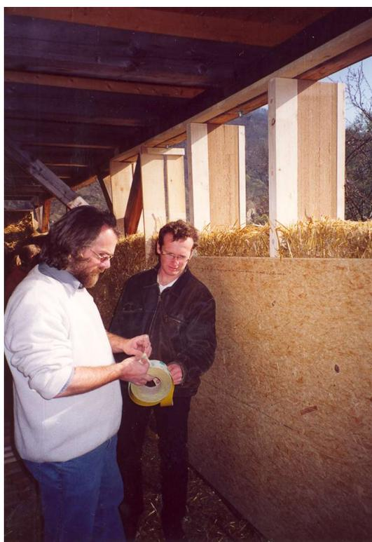
Abbildung 45 Außenwand mit OSB-Platte
