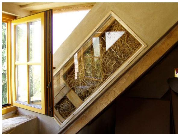
Abbildung 1 Strohdach-Dämmung
