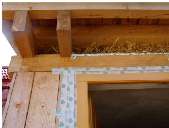
Abbildung 25 Luftdichtung vor Verschalung
