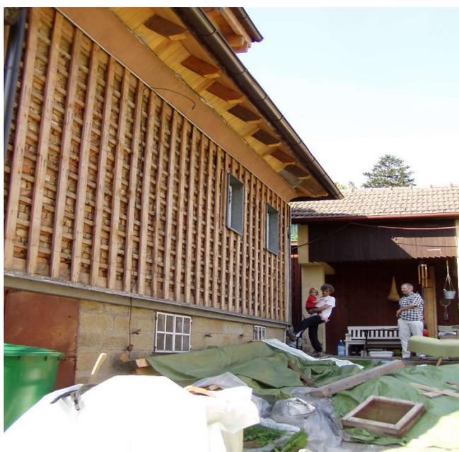
Abbildung 19 Westwand mit demontierter Wetterschale
