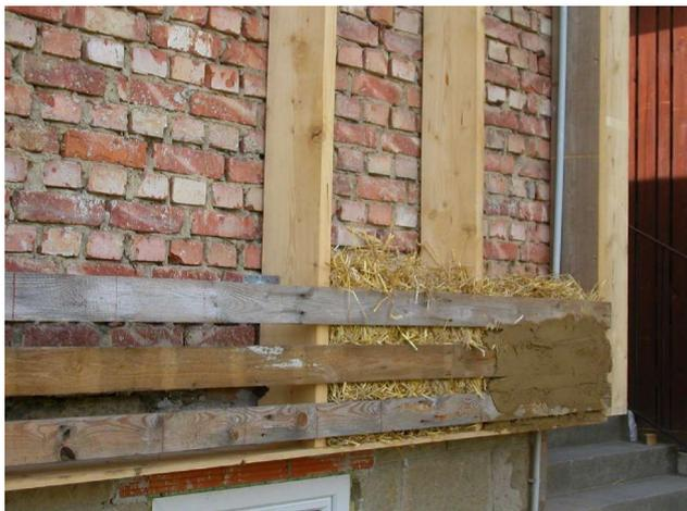
Abbildung 6 Strohdämmung mit Sparschalung
