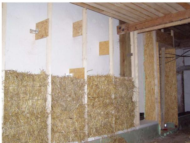
Abbildung 2 Innendämmung der Mühle in Krtiny
