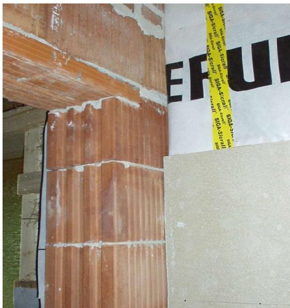
Abbildung 31 Zwischenwand vor Dampfsperre und F30 Verkleidung
