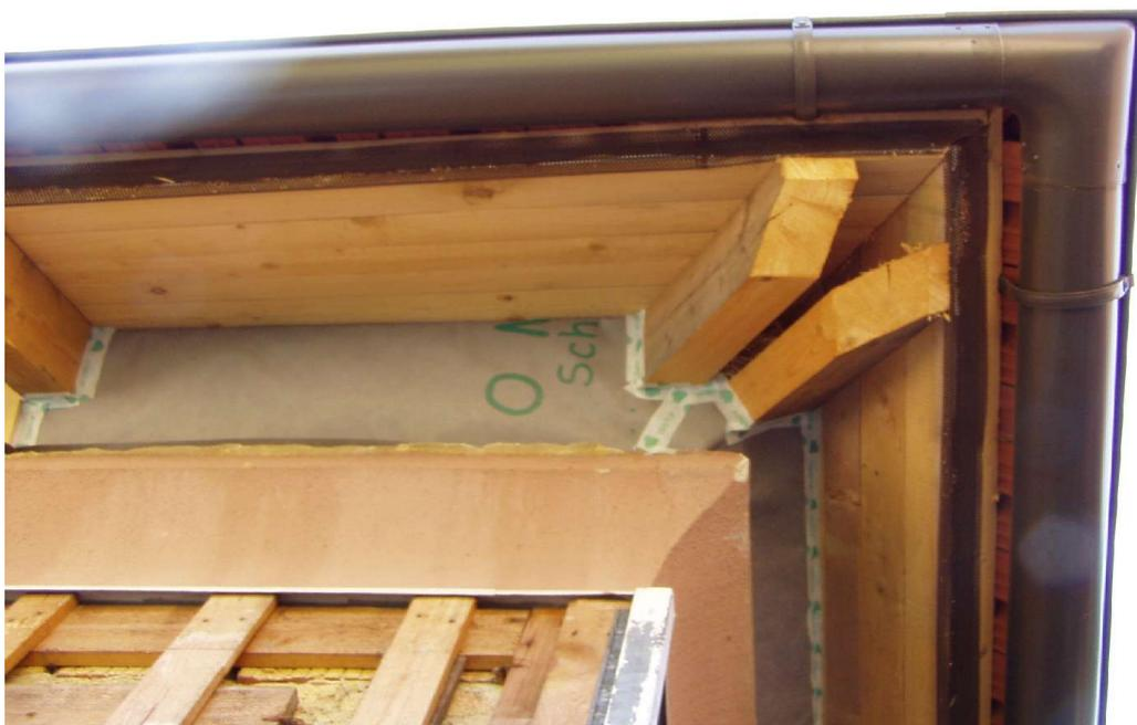
Abbildung 7 Aussenwand mit Anschluss an Dachdämmung
