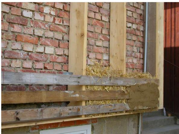
Abbildung 21 Strohdämmung mit Sparschalung
