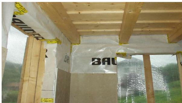
Abbildung 11 Dampfsperre innen an Fensterblindstöcke und Deckenbalken gedichtet
