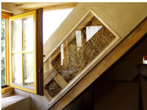
Im Dach sind ganze Kleinballen eingebaut, die Konstruktion darauf schwimmend angeordnet, sodass U-Wert neu < 0,13 W/m<sup>2</sup>K erreicht wird. Insgesamt kann trotz Teilsanierung bei Dämmung aller Wände eine Reduktion des Wärmebedarfes um 65 %-75 % (mit zunehmendem Austausch von Fenstern auf moderne Wärmeschutz verglaste neuen Fenster ist hier eine weitere Reduktion zu erwarten) erwartet werden, und das trotz erweiterter Wohnnutzfläche (Ausbau DG).
