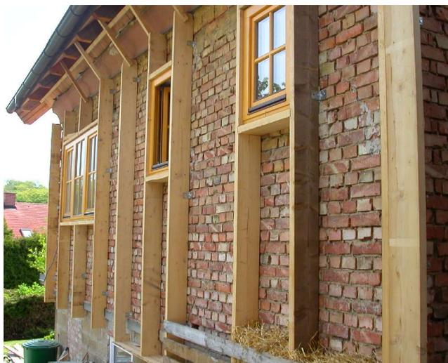
Abbildung 5 Westwand mit Holzpfosten für Strohfüllung
