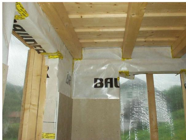
Abbildung 32 Dampfsperre innen an Fensterblindstöcke und Deckenbalken gedichtet
