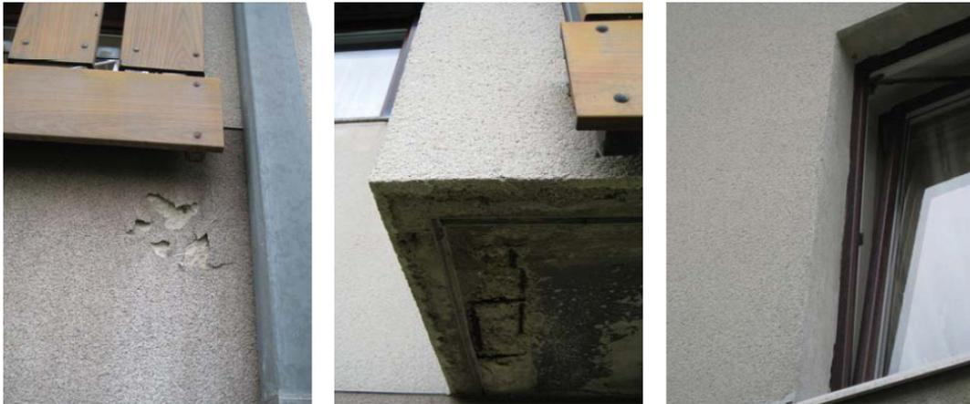
**Abbildung 75: Detailaufnahmen: Putzschäden – Balkonschäden – wenig Platz zur Leibungsdämmung – Foto © Franz Gugerell**
