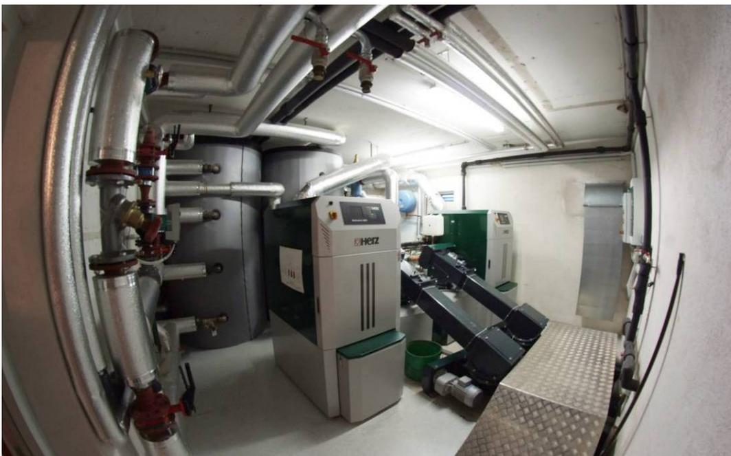
Abbildung 53: Beratungsobjekt Maria Anzbach, Heizungsraum mit Pellets-Tandemanlage und Pufferspeicher – Foto © Josef Gansch
