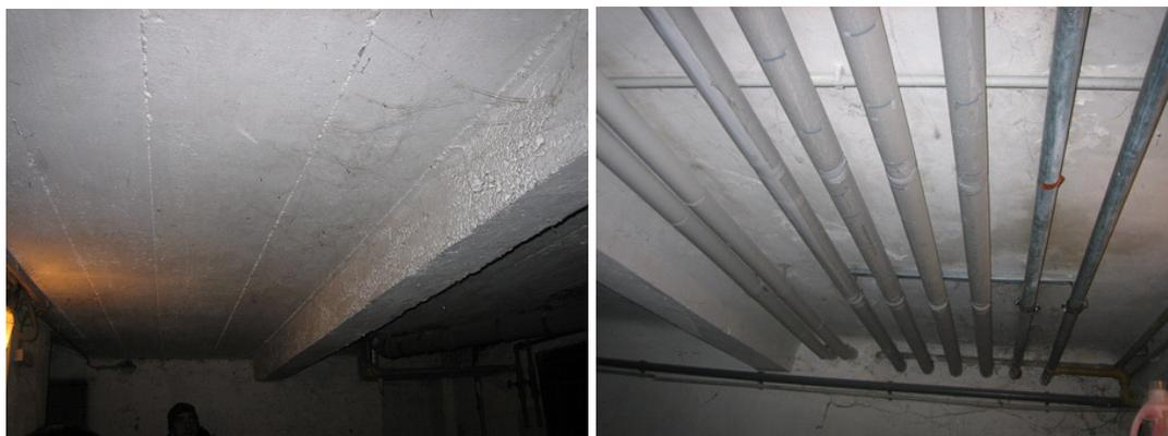
Abbildung 84: STB-Decke mit Rippen bzw. nur teilw. gedämmte Versorgungsleitung – Foto © Ulrike Wernhart
