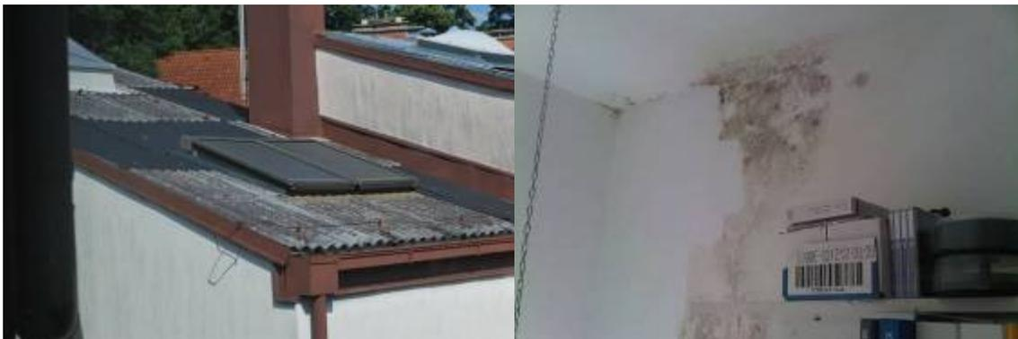
Abbildung 63: Purkersdorf – Detailansichten (Dach, Innenaufnahme mit Schimmel/Feuchtflecken an der Außenwand) – Fotos © Friedrich Brandstetter
