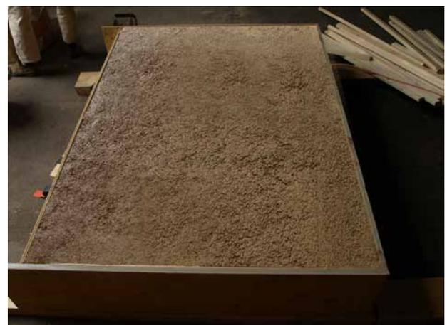
Lehm300 hat im Musterelement  $450 \text{ kg/m}^3$ . Nach dem Aufbringen der Stakenleisten wird die Lehmmischung aufgebracht, gerüttelt und dann abgezogen.
